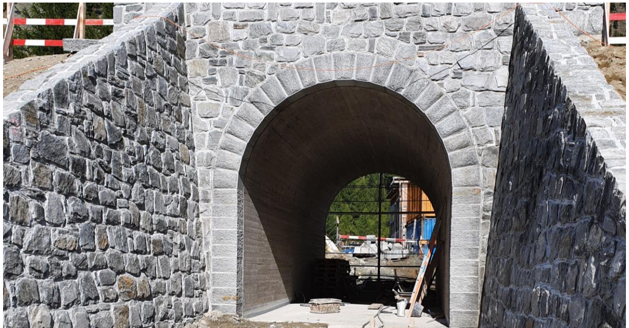
Detailpflege bei der neuen Wegunterführung zum «Märliweg»; September 2020
