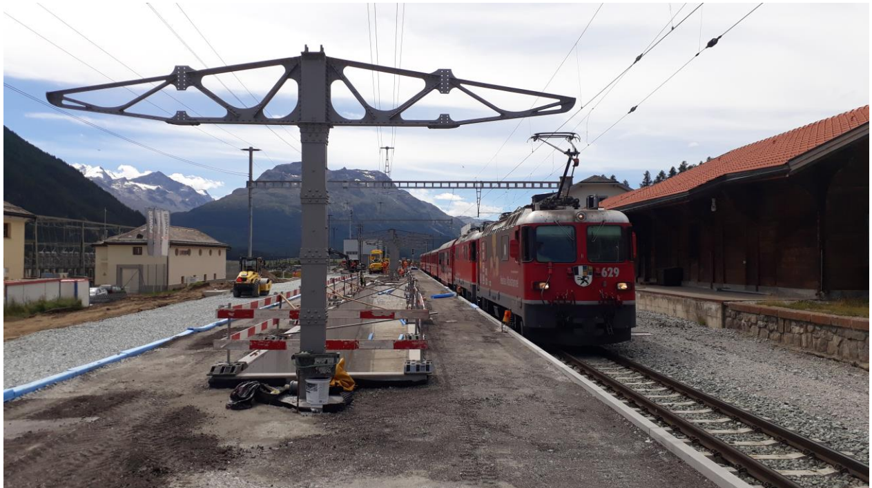
Montage Perrondach am Bahnhof Bever im August 2020
