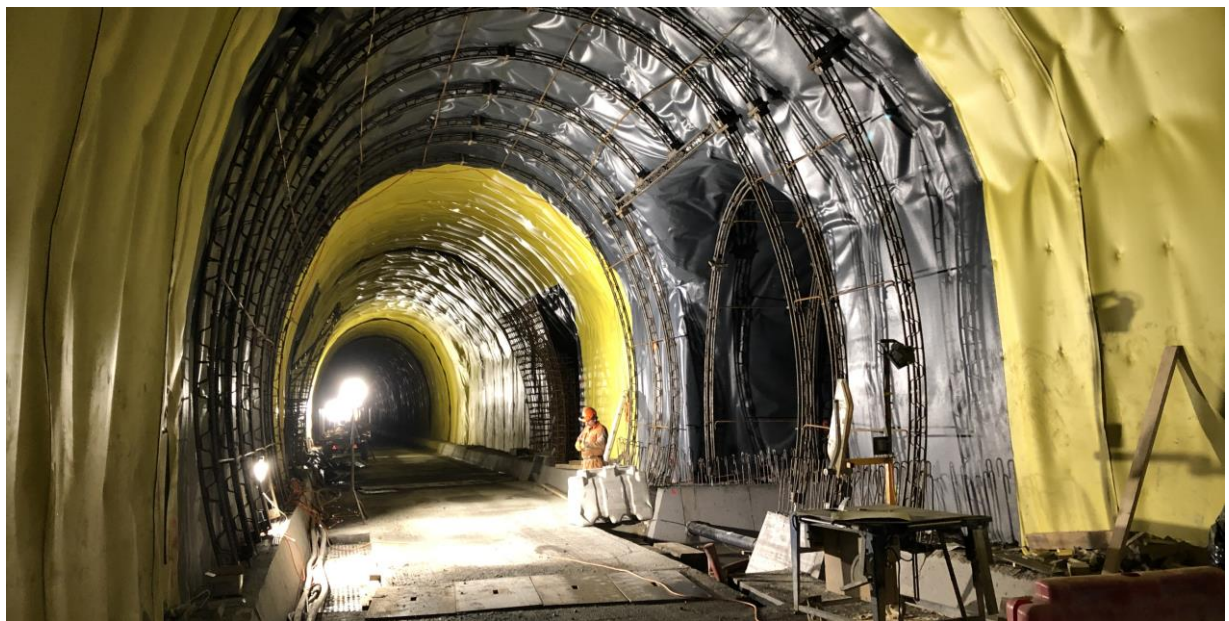
Abgedichteter Tunnelabschnitt Preda bei Querverbindung 1, Mai 2020
