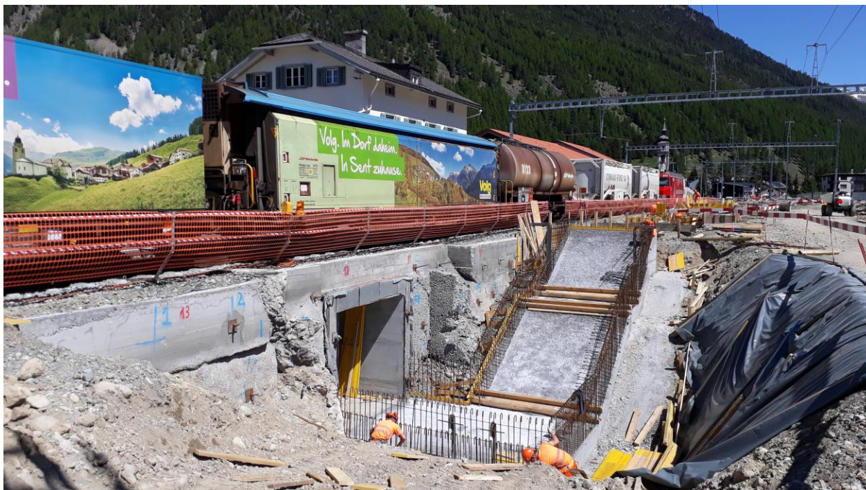
Baubetrieb im Bahnhof Bever, neue Personenunterführung mit Rampe, 27. Mai 2020
