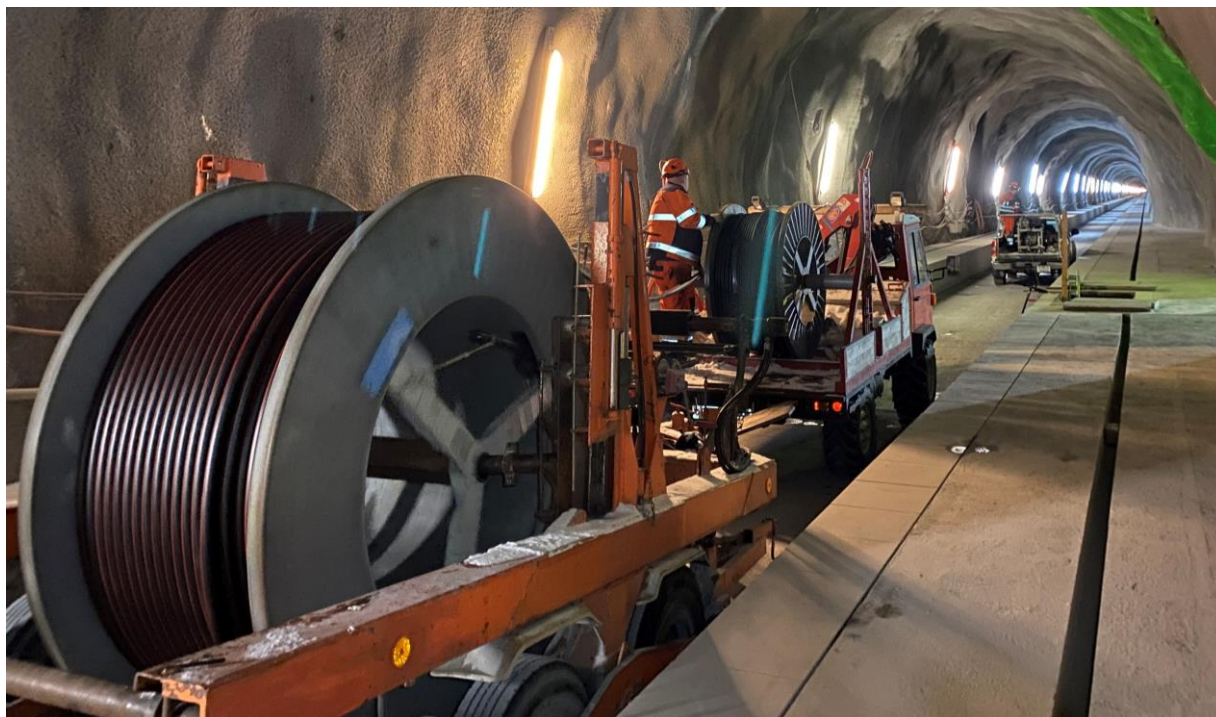
Blick in den neuen Albulatunnel: Einzug der Kabel in die Kabelkanalisation.
