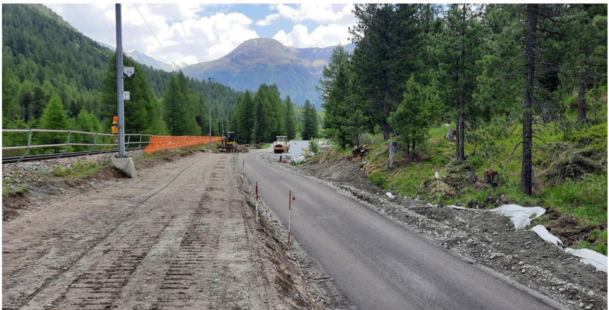
RhB-Strecke Spinas – Bever, Dammschüttung für Kurvenstreckung 2023.
