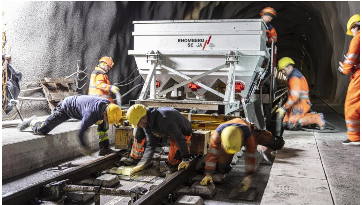
Blick in den neuen Albulatunnel: Millimetergenauer Einbau des «Feste-Fahrbahn-Systems»
