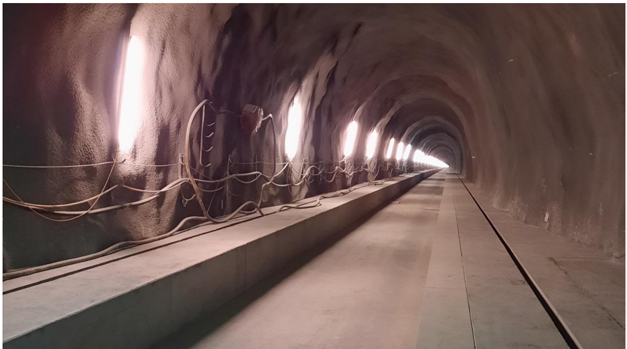
Blick in den neuen Albulatunnel: der Tunnelrohbau ist fertiggestellt.
